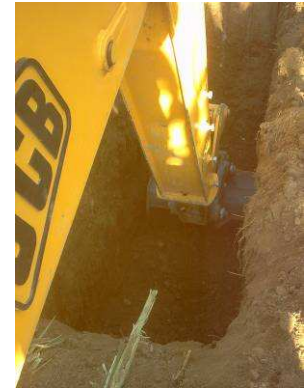
Sondage à la pelle mécanique
