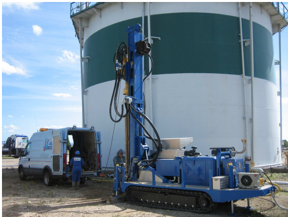
Réalisation d'un piézomètre de contrôle
